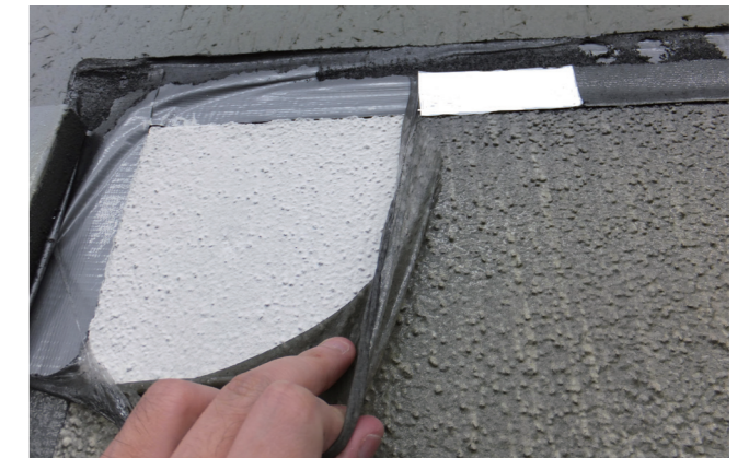
すす除去フィルムをはがしている様子(フィルムにすすが吸着されている)
