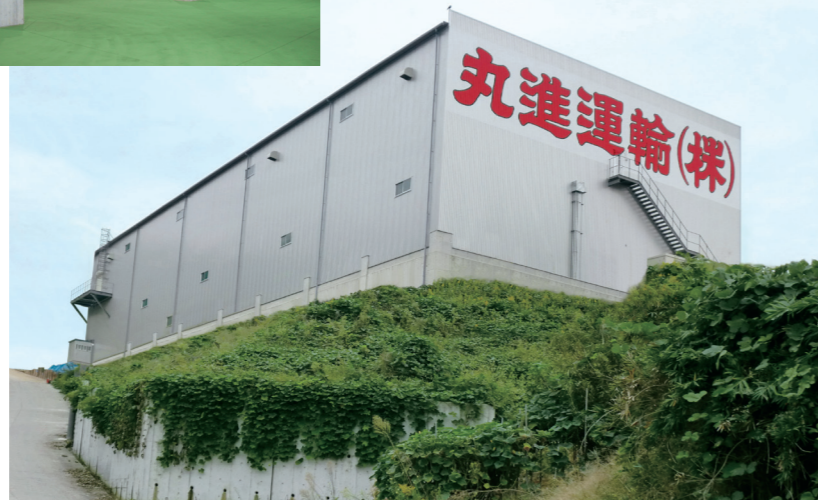
大阪倉庫物流センター
